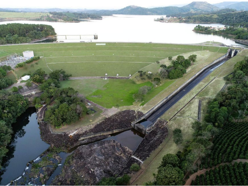
Procedimento anual avalia a capacidade da usina reiniciar suas operações de forma autônoma com o objetivo de reforçar a segurança do sistema elétrico
