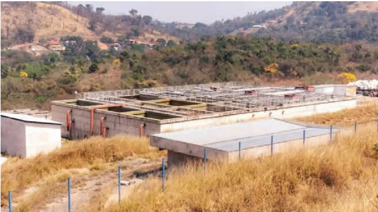
Uma das estações elevatórias do município, que anseia pela conclusão da obra, que muito beneficiará a cidade, principalmente à instalação de novas empresas e gerações de empregos
